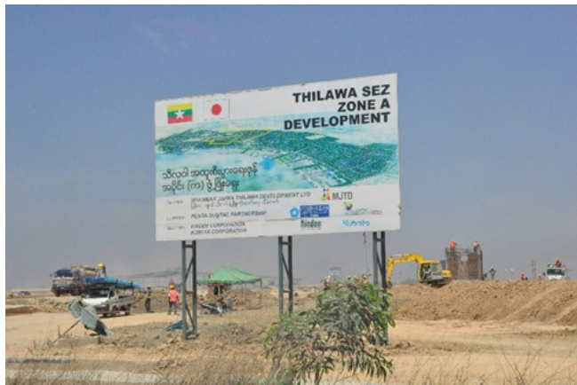
写真 建設が進むティラワ工業団地
