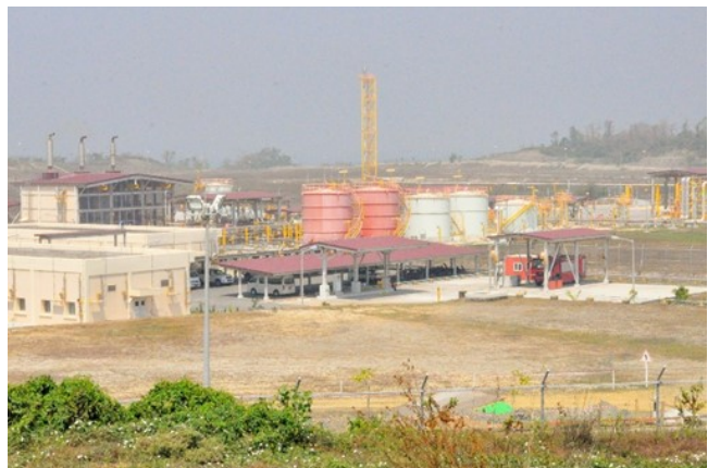
写真 チャウピューに建設されたガス基地
